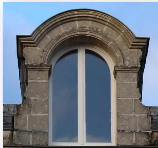
Lucarne sud (parc)
