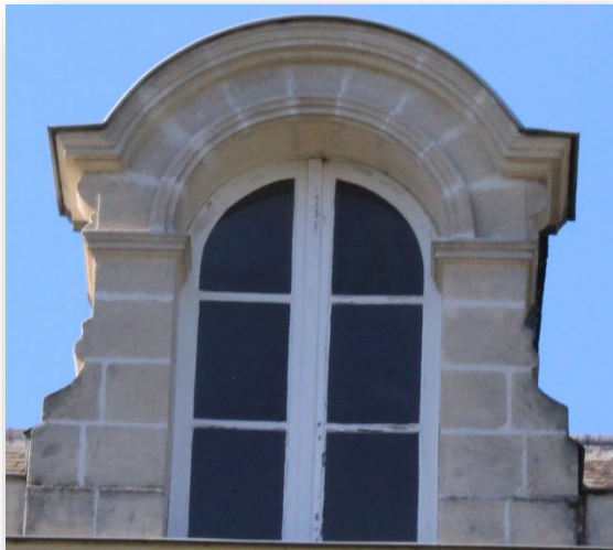
Lucarne nord (entrée)
